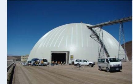
サンクリストバル鉱山の粉塵飛散防止の巨大ドーム
