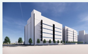
netXDC千葉第三センター
